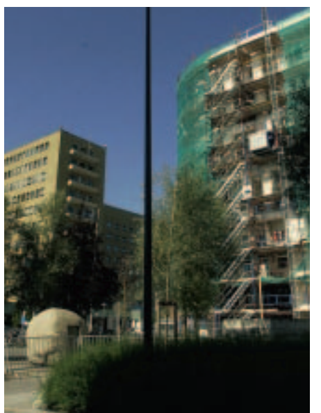
NYTT MØTER GAMMELT: Nevrosenteret er største bygg i fase 1. Det oppføres rett ved den gamle høyblokka. Hoveddelen er i bruk om knappe to år, én av fløyene allerede neste høst. Foto: STEINAR BENDIKSVOLD
