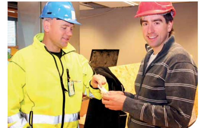
BORT MED SVINN: – Kostnader og feilmedisinering går ned når Automatisert Legemiddelforsyning innføres på St. Olav, forteller Bjørn Bakken og Helge Ovesen som er i full gang med å bygge om 1. etasje i sykehusapoteket på St. Olavs Hospital for å sette inn det nye anlegget for automatisert legemiddelforsyning.
