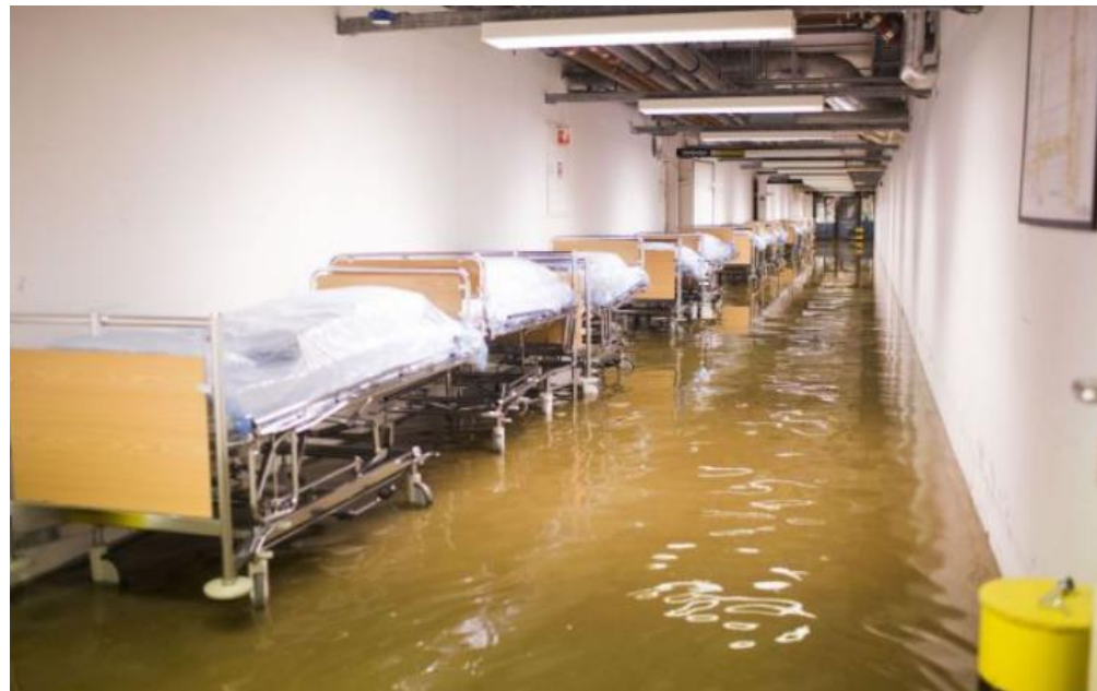
Flom i Sørlandet Sykehus, Kristiansand i 2016. 26 millioner i reparasjoner og 11 mill. i klimatilpasningstiltak.
