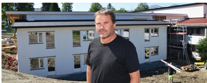
Det nye bygget vil være innflyttingsklart rundt 1. oktober, forteller daglig leder Steinar Volden. Foto: Helse Midt-Norge RHF
